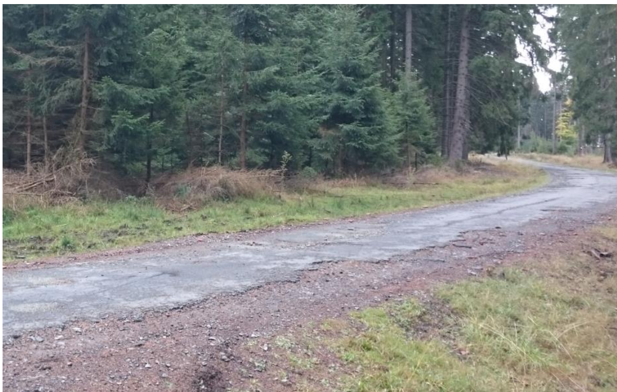
Fot. 7 Zaawansowana destrukcja nawierzchni asfaltowej
