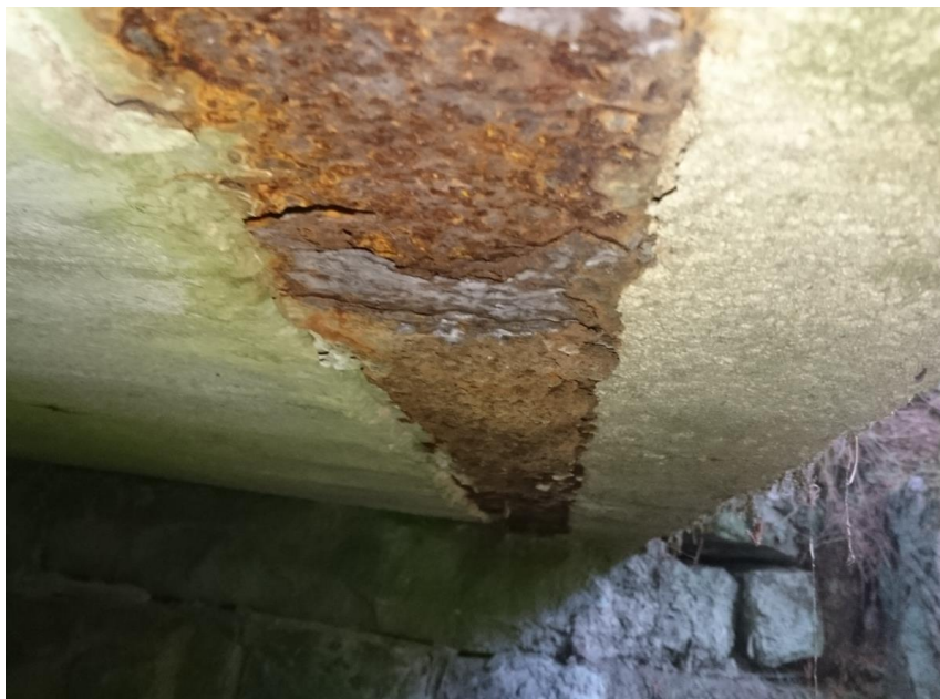
Fot. 4 Zaawansowana korozja dolnej stopki kształtownika stalowego – obiekt nr 2
