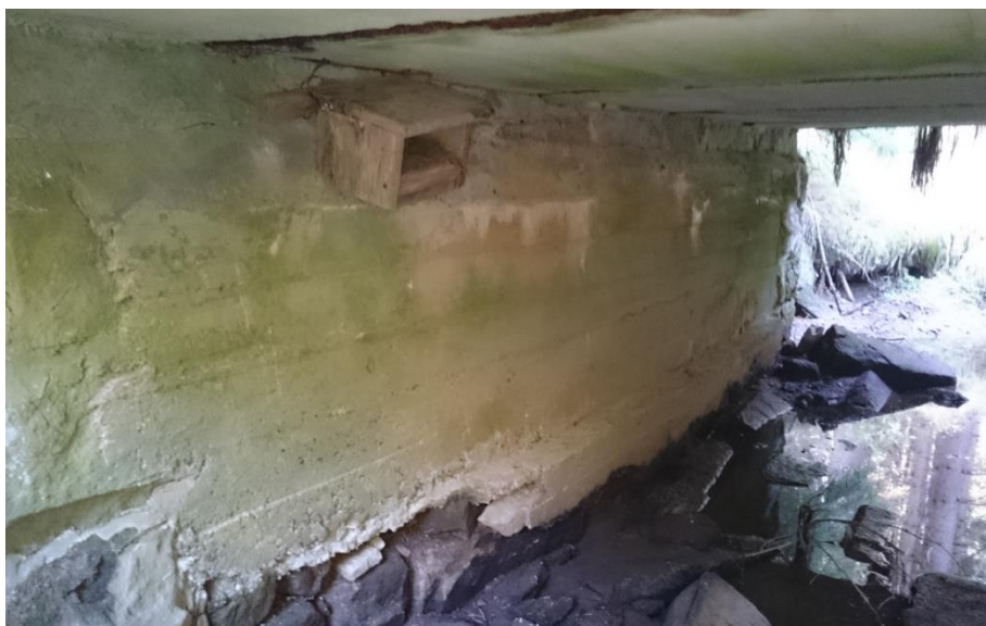
Fot. nr 5 Wzmocnienie filarów mostowych – obiekt nr 2
