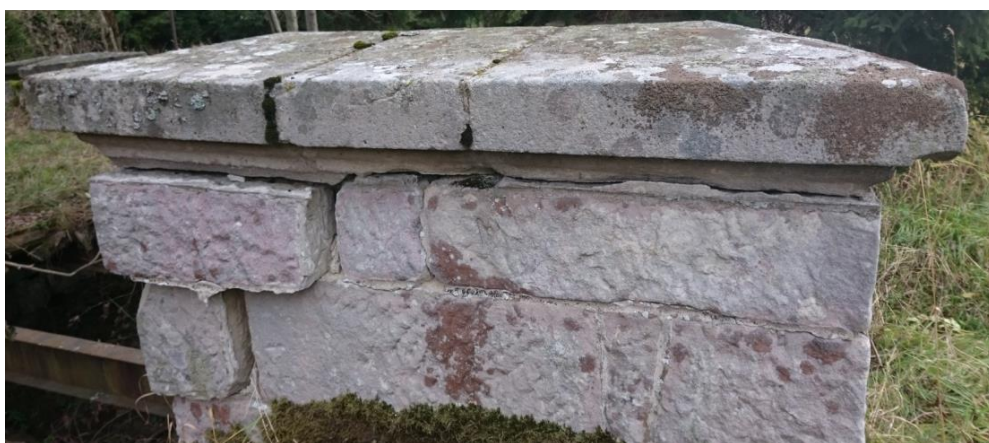
Fot. nr 2 Degradacja elementów kamiennych – obiekt nr 1
