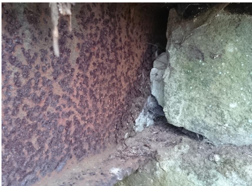
Fot. nr 1 Korozja stopki gorącowalcowanego kształtownika stalowego – obiekt nr 1
