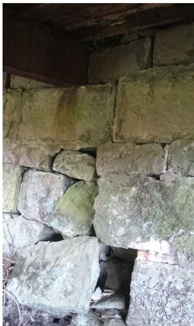
Fot. nr 3 Degradacja elementów kamiennych – obiekt nr 1
